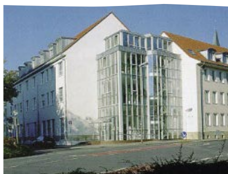
Das IMIS der Universität Osnabrück am Neuen Graben.
